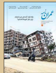
زلزله ترکیه ۱۷ بهمن ۱۴۰۱، منطقه ختای عکاس: حلیه هکل اوغلو
